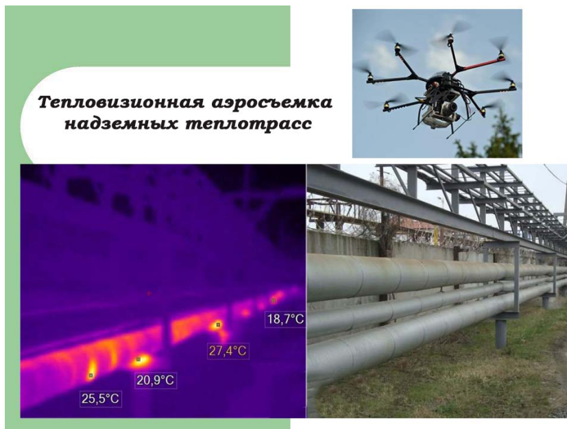
Тепловизионная аэросъемка надземных теплотрасс
